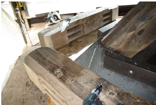
De zeteldelen met ingelijmde nieuwe stukken liggen klaar op de steiger. De zwaluwstaarten worden ter plekke nog aangebracht. (foto: G. van Stekelenburg)
