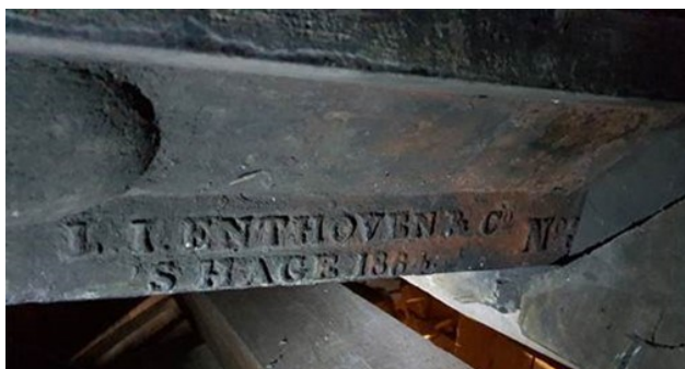
Na wat hak- en breekwerk kwamen de gegevens van de as vrij: de naam van de gieterij 'L.I. Enthoven & Co' Deze naam is waarschijnlijk voortgekomen uit het feit dat de Joodse eigenaar een poos in Eindhoven woonde en daarom deze naam aannam. *) (foto: Marc van Deursen)
