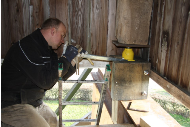
Vanaf een steiger onder de kast wordt de kast omhoog gedrukt m.b.v. een potkrik (foto: G. van Stekelenburg)
