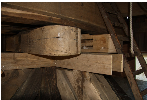
De gerestaureerde zetelstukken worden aangebracht met behulp van tijdelijke ondersteuning aangebracht tegen de steekbanden. (foto: G. van Stekelenburg)
