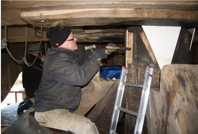
Met behulp van een mal worden de zwaluwstaartverbindingen op de stander aangepast. (foto: g. vn Stekelenburg)
