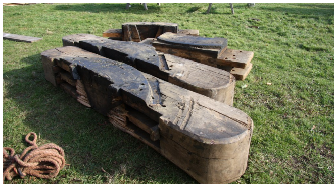
De verwijderde zetelstukken in het gras naast de molen. (foto: G. van Stekelenburg)
