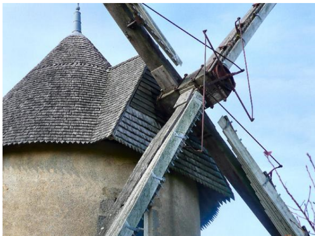
Door middel van drijfstanden, bevestigd aan een kroon aan de voorkant van de askop, wordt het systeem van binnenuit bediend met behulp van een differentieelmechanisme. (foto: www.moulins-a-vent.net )
