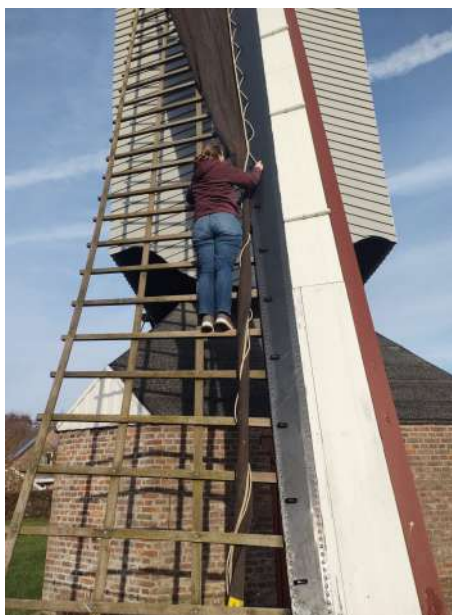
foto 4: Het zeil blijft opgerold tot bovenaan en van boven naar beneden worden de litsen vastgezet. Hierbij rolt het zeil vanzelf af. Het opgerolde zeil is eenmaal door een heklat gestoken, dit hoeft echter niet.
