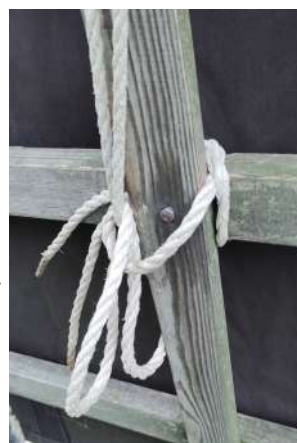
foto's 5: boven: Beide slaglijnen zitten al vast onder: Het uiteinde van de tweede lijn is voorlangs naast de eerste lijn gelegd
