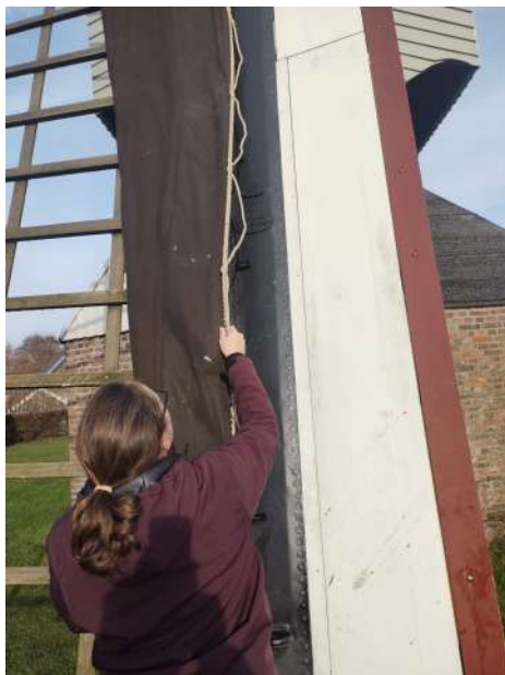
foto 3: met een draaiende beweging vanuit de pols worden de litsen achter de kikkers geslagen
