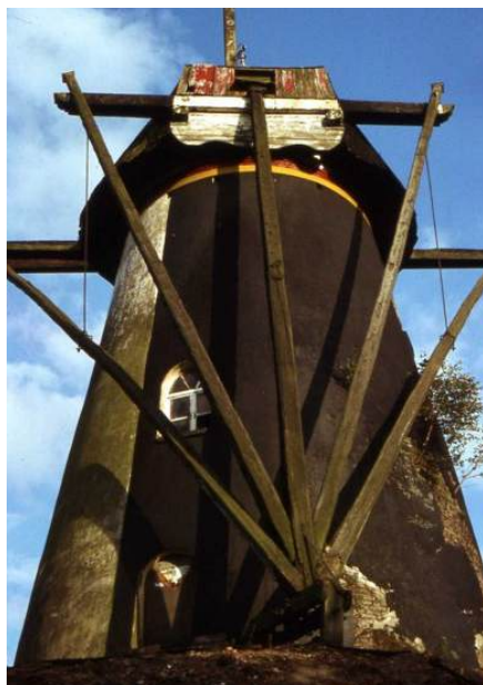
Sint Victor tijdens en na de restauratie van 1984, deels ongestuct. (foto's uit het archief van Gerard Sturkenboom)
