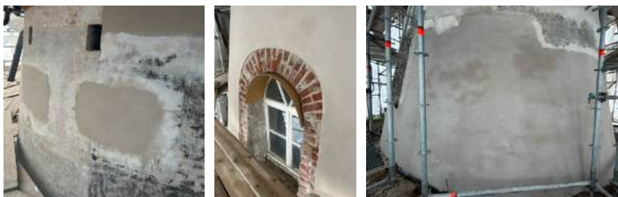
Het nieuwe stucwerk, nog niet helemaal droog.
