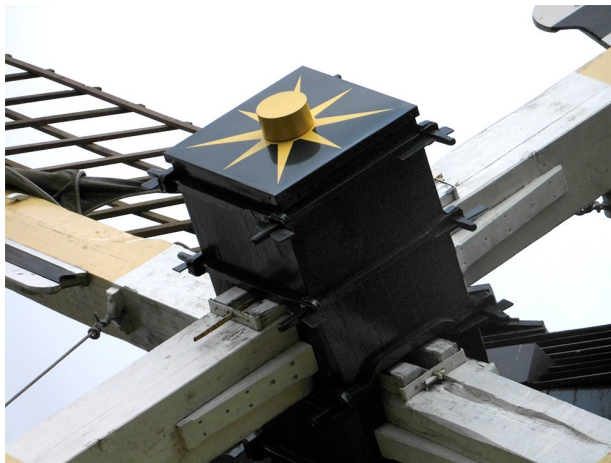
De houten askop van de standerdmolen in het openluchtmuseum in Arnhem. In 2021 ging deze as er uit en werd door een nieuwe, houten, bovenas vervangen. (foto: Coen Manche, molendatabase)
